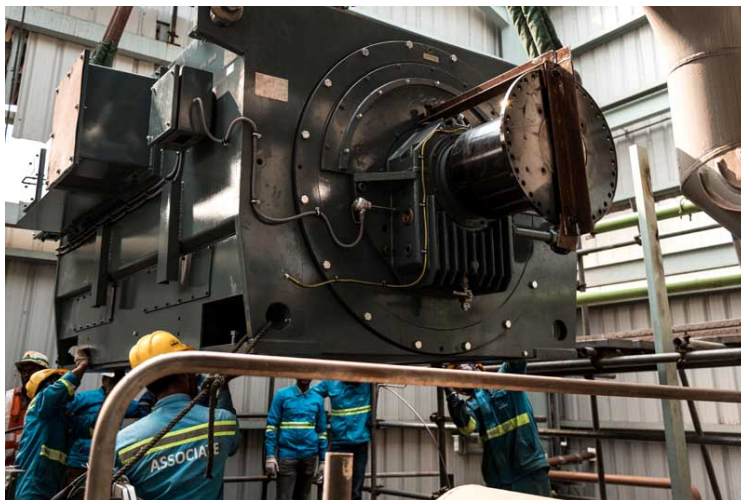
Bild: Menzel baute den Motor schnell aus seinem modularen Sortiment und sorgte mit individuellen Anpassungen für eine reibungslose Installation und Inbetriebnahme
